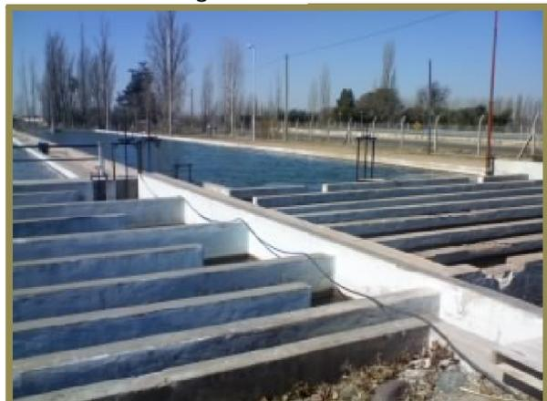
posterior, generando sobrecargas de fangos, depósitos en las conducciones hidráulicas, tuberías y canales, y disminuyen la capacidad hidráulica. En este proceso la retirada de estos sólidos se realiza en depósitos donde se remansa el agua, se reduce la velocidad del agua, aumentando la sección de paso (Hernández Muñoz, Depuración de aguas residuales, 1992).
