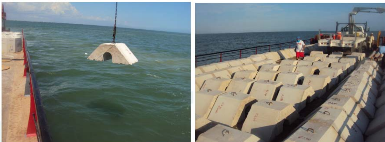
Fig. 5.4 Reforzamiento de la línea submarina Chiquila-Holbox.
