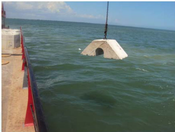
Fig. 5.4 Reforzamiento de la línea submarina Chiquila-Holbox.
