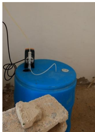
Figura 7. Equipo de desinfección.
