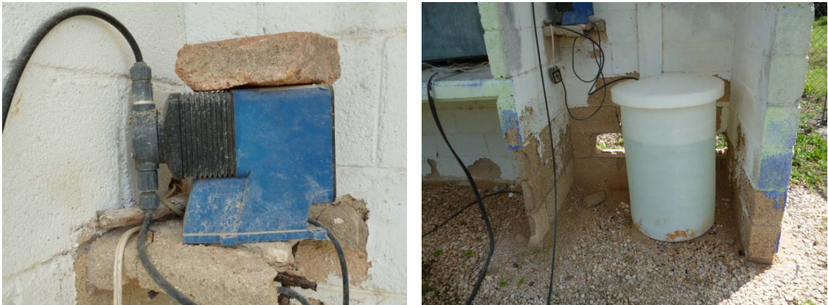
Figura 7. Equipo de desinfección.
