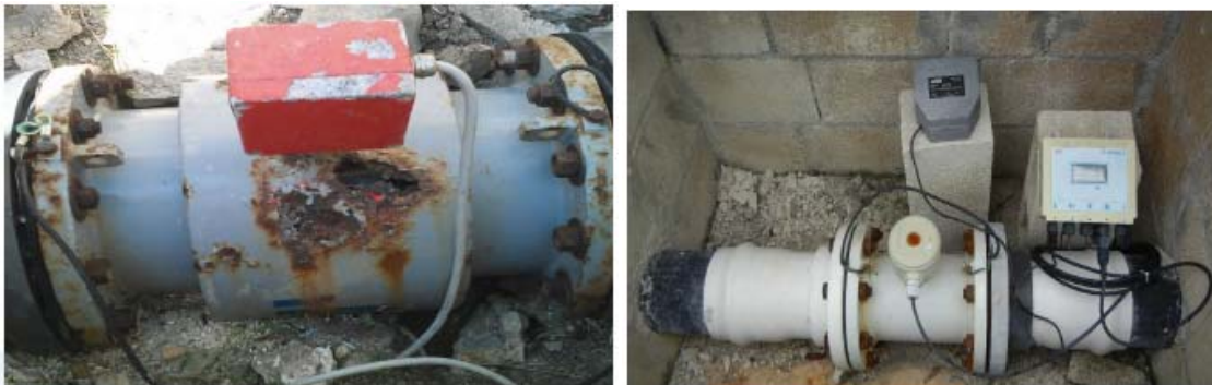
Fig. 5.13 Macromedidor de 10" al inicio de la línea submarina, fuera de operación por 4 años y macromedidor de 6" al final de la línea submarina, fuera de operación por 3 años.
