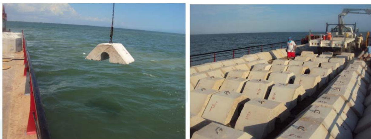
Fig. 5.4 Reforzamiento de la línea submarina Chiquila-Holbox.
