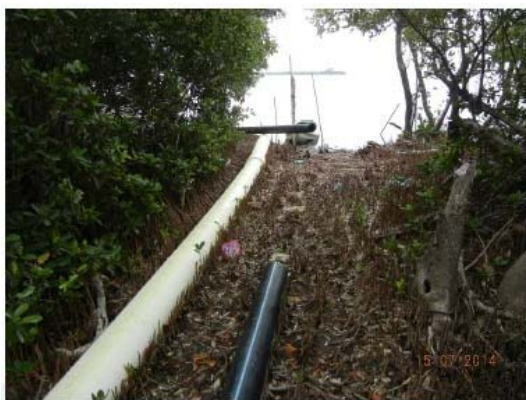
Fig. 5.8 Salida de línea submarina en Holbox, junto a línea antigua de 6".
